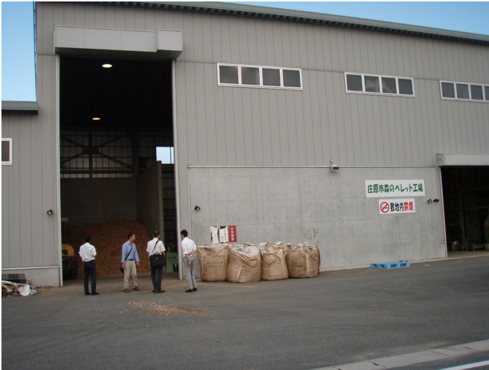
写真1 庄原市森のペレット工場の外観
