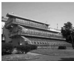
図1 生物環境調節実験施設外観 温室、3種類のチャンバー、実験室等からなる施設で、建物南側の1、2階が環境制御可能な材料提供温室、3階は自然光型チャンバーとなっている。
