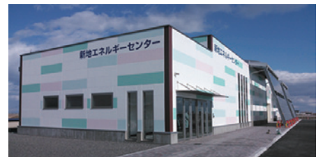
新地エネルギーセンター
